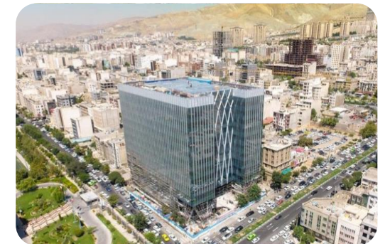
ساختمان بورس اوراق بهادار محل پروژه: تهران کارفرما: شرکت تکناب
