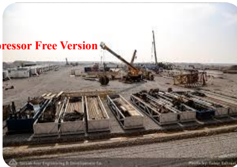
پروژه نفتی یادآوران اهواز محل پروژه: اهواز کارفرما: شرکت پادکاو انرژی
